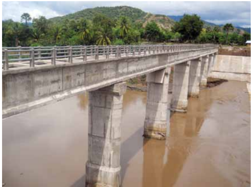
Talang air jaringan irigasi Mbay Kiri yang menyeberangi sungai Aesesa
